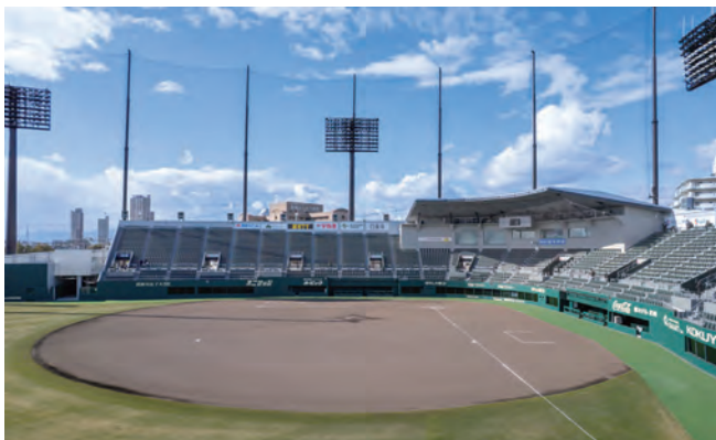
▲新たなファーム拠点となった日鉄鋼板SGLスタジアム尼崎
