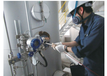
▲ばい煙等の測定立入検査の様子
