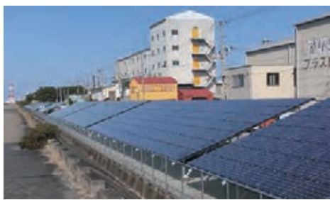
▲南二見人工島の市有地を活用した太陽光発電施設設置
