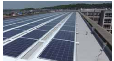
▲三木北高校のパネル設置状況
