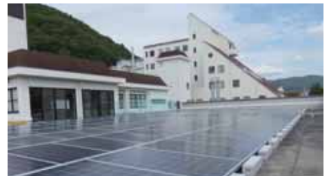
▲光風病院のパネル設置状況
